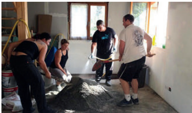
Chantier ARA - Source Compagnons bâtisseurs
