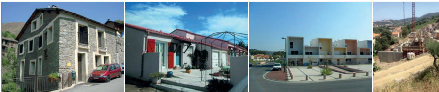
Logements sociaux à Osséja, Saint André, Céret et en construction à Banyuls-sur-Mer (source Office 66)
