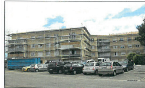
Photos du chantier
