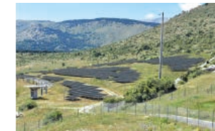
Engie Green Bifaziale Photovoltaikanlage
