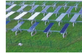
EDF Renewables Nachgeführte Photovoltaikanlage
