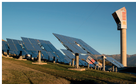
CNRS PROMES Centrale solaire thermodynamique à tour
