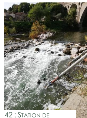
42 : STATION DE POMPAGE
